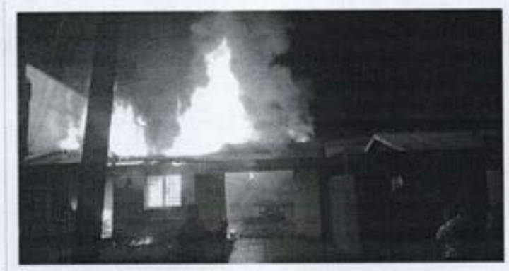
Fotografía N°7: Incendio Estructural, Antillanca N°1230
