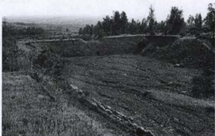
Fotografía N°3: Piscina decantadora, Quebrada de Macul.
