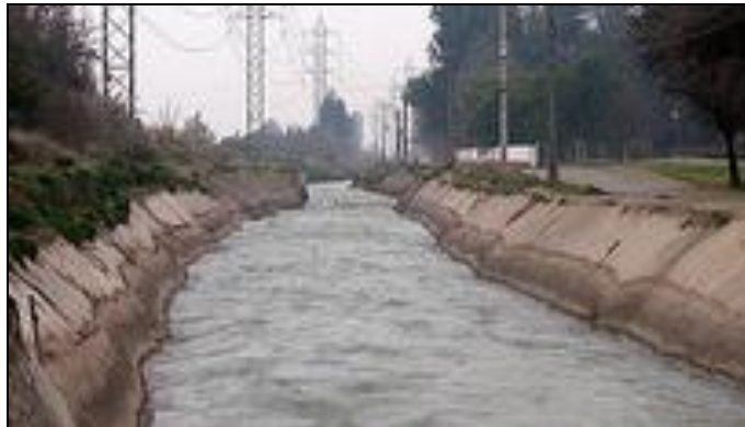
Figura 5.4. Canal San Carlos a la altura de Av. Las Tinajas.
