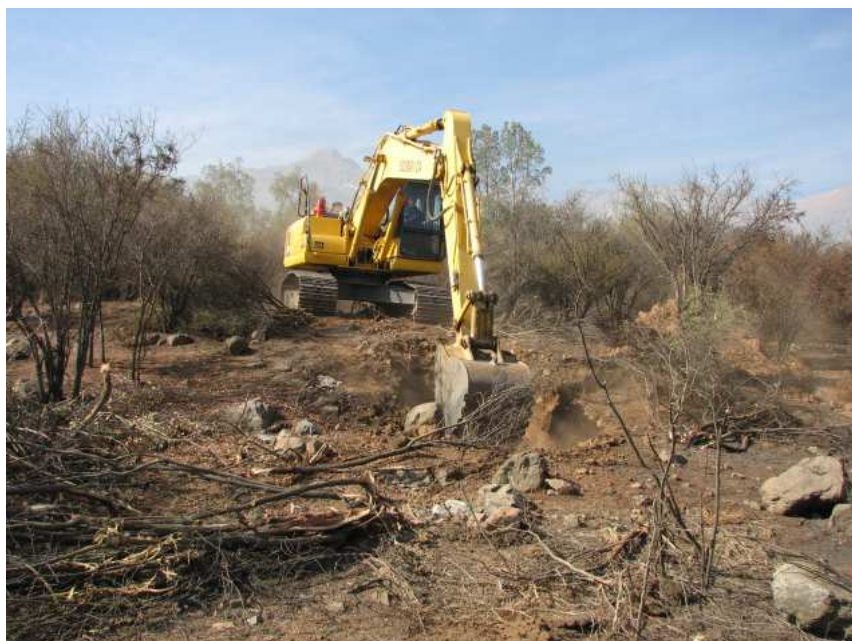
Figura 2. Excavación de las trincheras en un escarpe de falla que afecta las unidades de abanicos aluviales más recientes en el piedemonte del sector oriente de Santiago.
