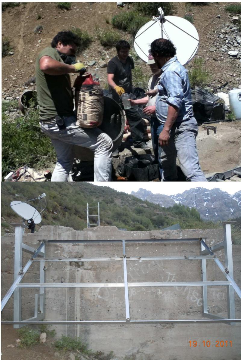
**Estación sismológica Las Melosas: Construcción e instalación de la infraestructura de muros de contención contra rodados, estructura para los paneles solares, instalación de antena satelital.**
