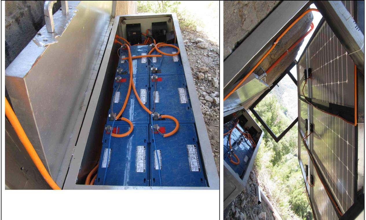
**Sistema power-supply (baterías) y paneles solares de la estación sismológica Las Melosas.**
